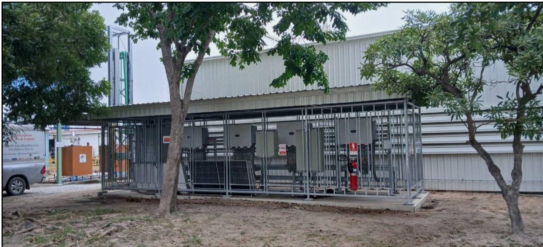
ภาพที่ 1.7 การติดตั้งเครื่องแปลงกระแสไฟฟ้า (Inverter) บริเวณด้านหลังอาคารสาขการผลิตแผ่นเหล็กเคลือบโลหะ 1 (MCL1)
